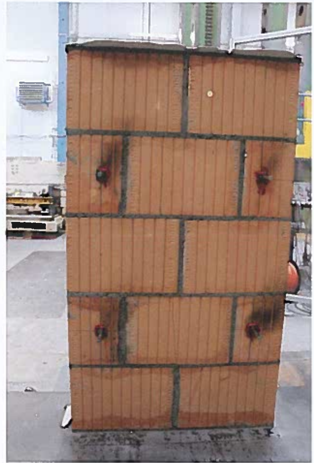
Abbildung 8: Mauerwerkskleinkörper Nr. 3.1 nach Versuch. Sichtbare vertikale Risse. „Rückseite“.
