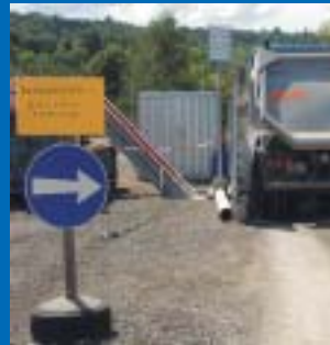
Kein LKW verlässt die Deponie, ohne die automatische Rad-Waschanlage zu passieren.
