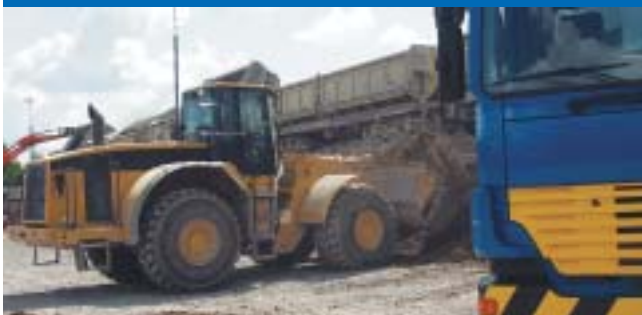
Ein elektrifiziertes Anschlussgleis ermöglicht eine umweltschonende Anlieferung grosser Mengen von Inertstoffen aus Grossbaustellen. Bis 1200 Tonnen Material können «in einem Zug» angenommen werden.
