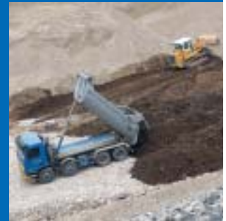
Der Deponiewart hat die vorgeschriebene Fachausbildung absolviert. Er garantiert den Einbau von kontrolliertem Material.
