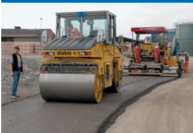
Einbau des Belags.
