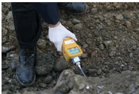
Überwachung des Aushubs mit dem PID (Photoionisationsdetektor)
