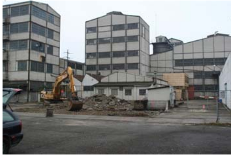
Abbruch der Betonbodenplatte und Abziehen des Kieskoffers
